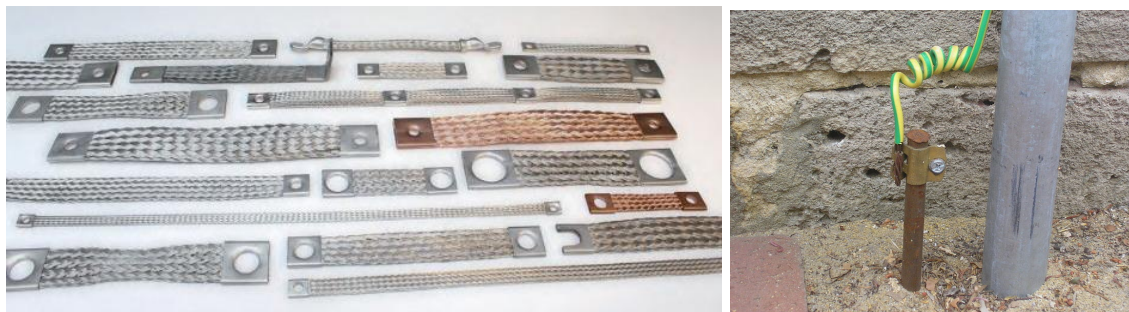
FIGURE 5 – Gauche : pour relier des carcasses et des circuits à la masse, la connexion doit être la plus courte possible, et avoir une surface de contact maximale, donc par sa forme en nappe, la tresse de masse est le conducteur le plus adapté à cette utilisation. Droite : piquet de terre en acier galvanisé (environ 60 cm de long) planté dans le sol au pied d'une maison (on remarque le fil normalisé rayé vert et jaune de mise à la terre).
