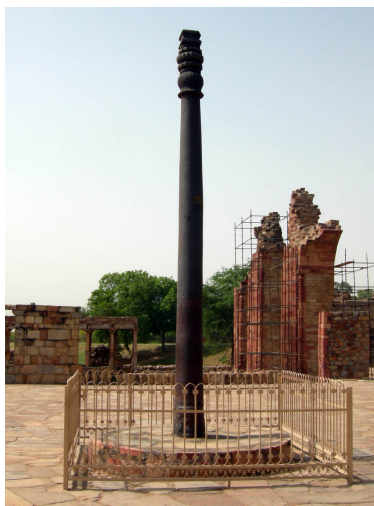
Figure 4.2 – La tour de Delhi. Elle fait environ 6 tonnes. C'est probablement une couche en surface à haute teneur en phosphore qui permet de passiver efficacement l'acier.
