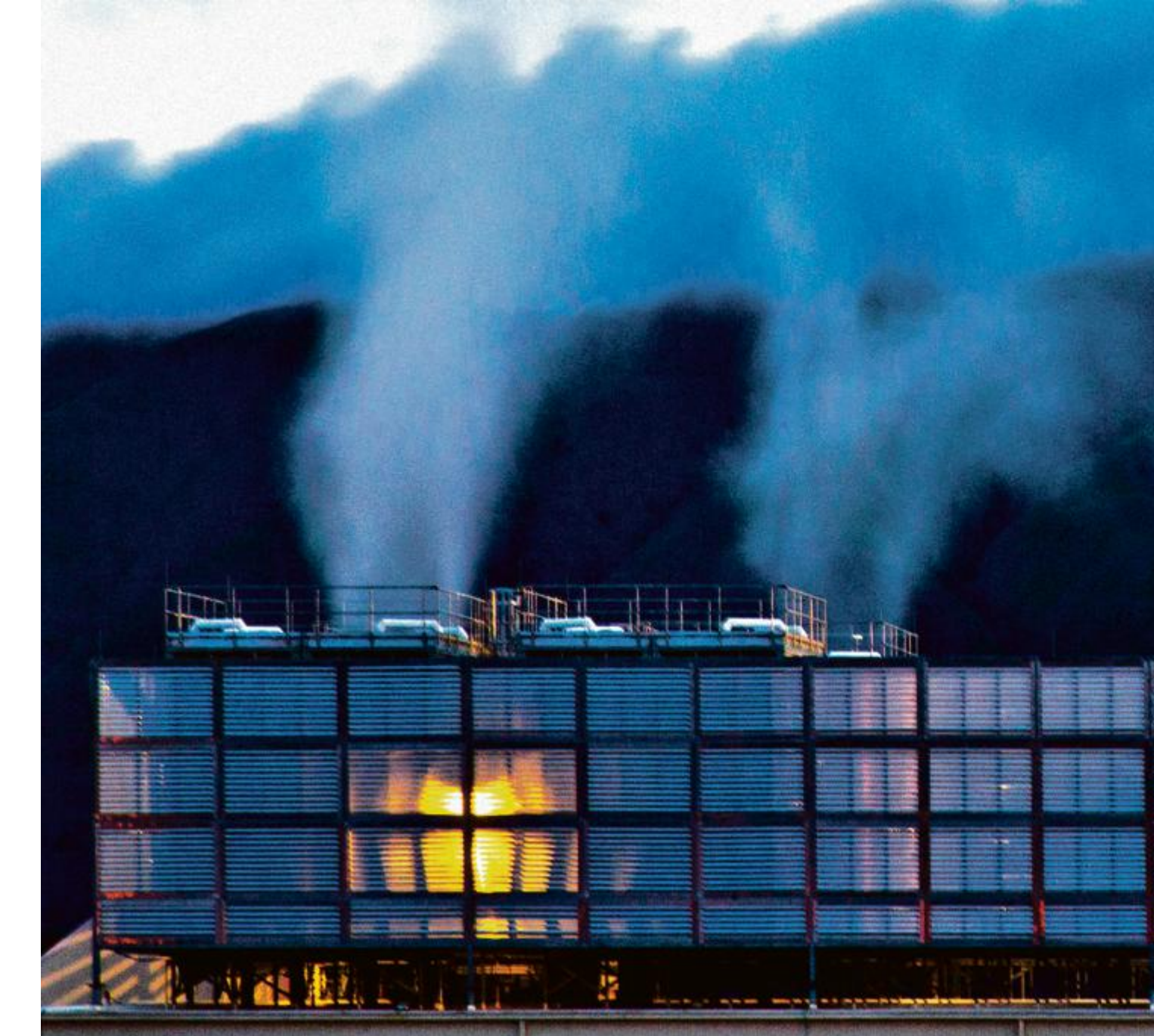
VORACE Les cheminées de refroidissement du data center de Google, à The Dalles (Oregon). Celui-ci consomme autant d'énergie que
