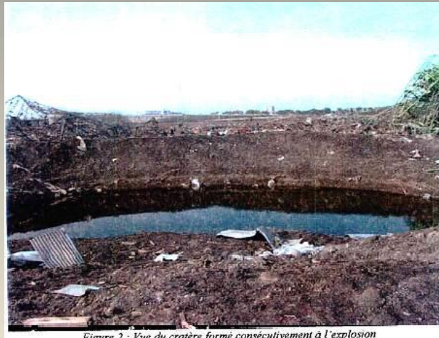
Figure 2 - Vue du cratère formé consécutivement à l'explosion
