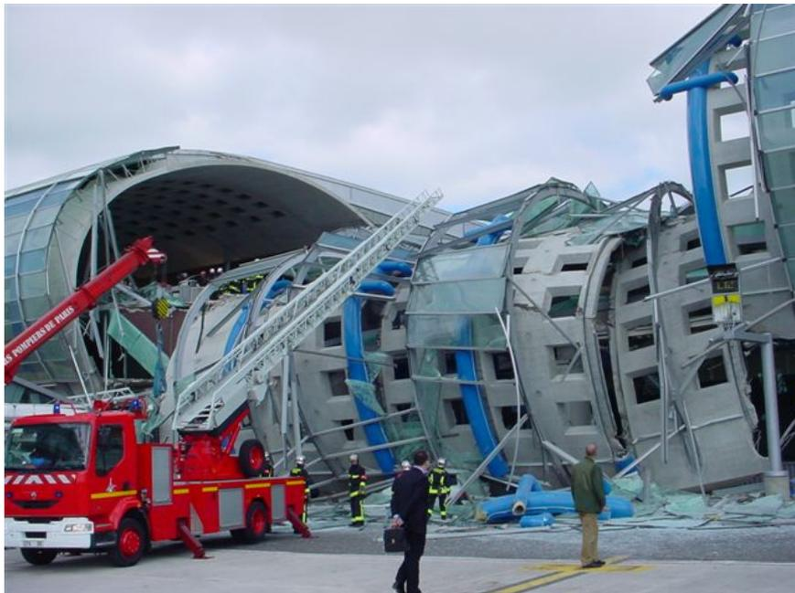
FIGURE 1 – Le 23 mai 2004, une partie de la voûte coiffant le terminal 2E de l'aéroport Charles de Gaulle à Roissy s'effondre, un an après sa mise en service. L'enquête a conclu à l'effondrement d'une structure dont la réserve de résistance initiale était faible. Ainsi, la structure était stable, mais s'est progressivement fragilisée.
